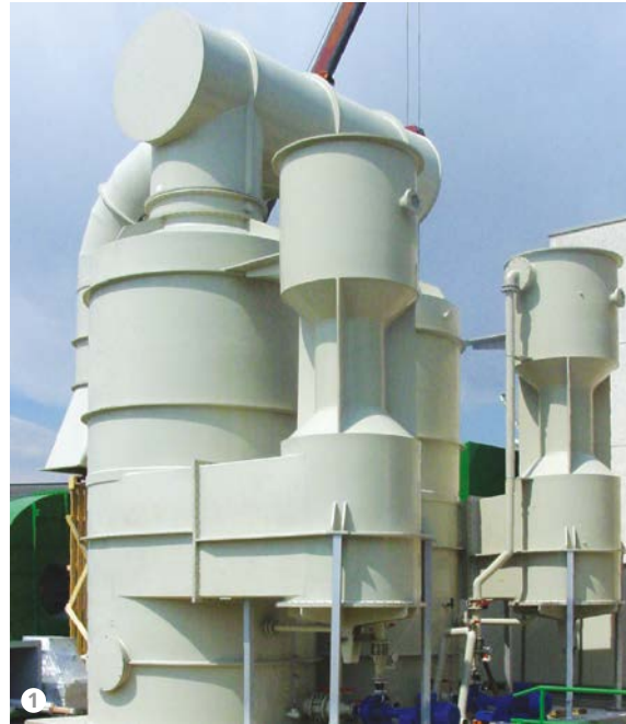
Figura 1: Impianto di filtrazione ad umido tipo scrubbers Venturi.
