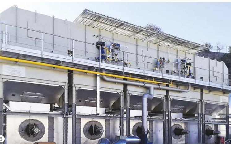
Figura 3: Ossidatore termico rigenerativo RTO.
